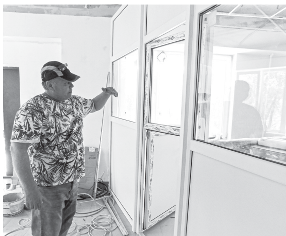
О ходе ремонтных работ рассказывает И. Патмалник
