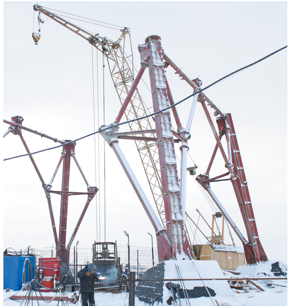
Над строящимся шахтным стволом возведена металлоконструкция будущего копра
